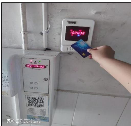
上图为实体卡刷水消费示意图。卡片贴上开阀，拿走关阀，注意直饮水机开阀后要手动按直饮水机上的按钮放水。请同学们注意阅读机具旁边张贴的操作说明。
